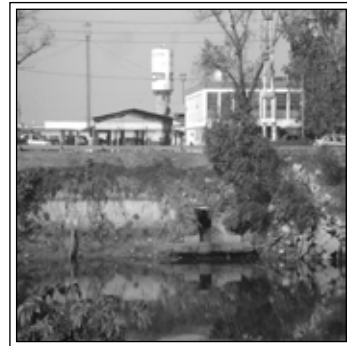
Imagen 5. Desagüe fabril, altura del Puente La Noria.
